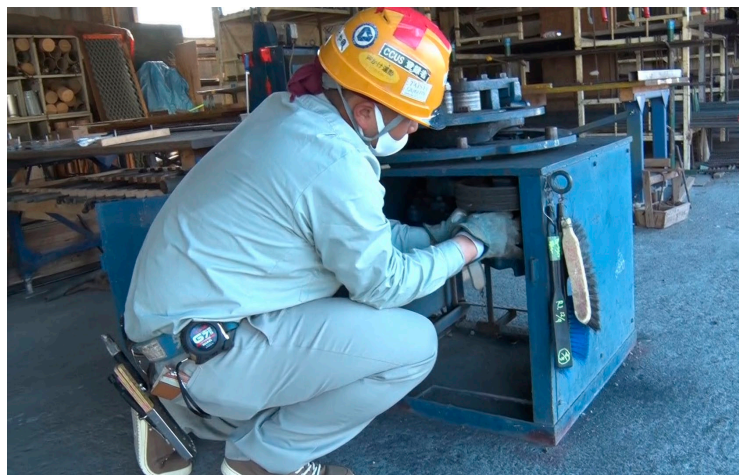
<鉄筋曲げ機の調整>
