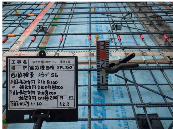
<スラブの検査>
