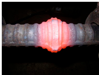
圧接による接合部分
